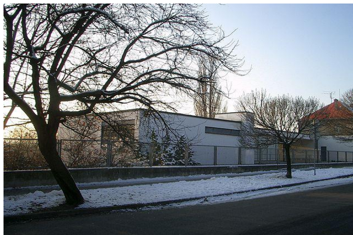
Obr. 4 - Vila Tugendhat, pohled z ulice
